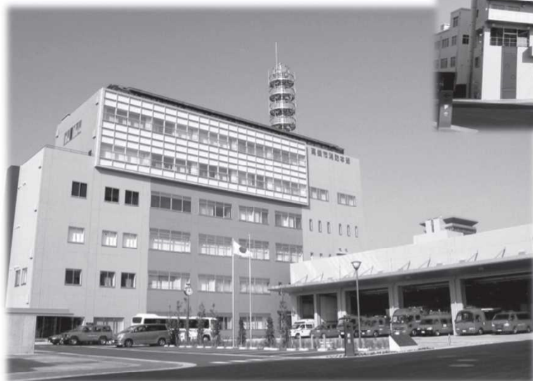
消防本部・中消防署合同庁舎
