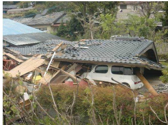
立野地区被害状況
