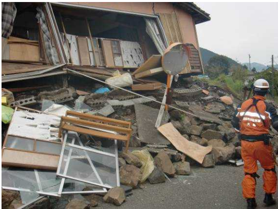
立野地区被害状況
