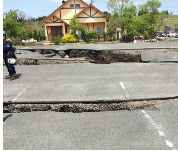
高野台地区道路の被害状況
