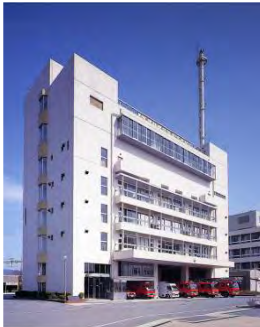
消防本部・中消防署（合同庁舎）
