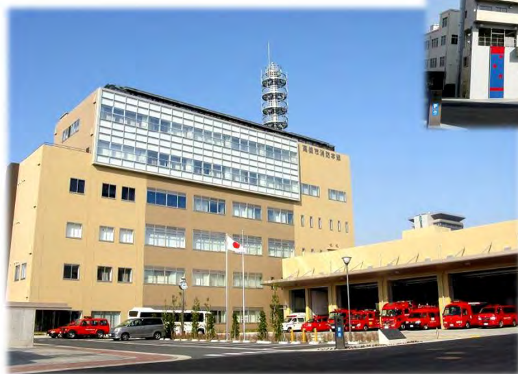
消防本部・中消防署合同庁舎
