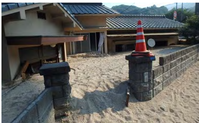
・被害状況（小屋浦地区）
