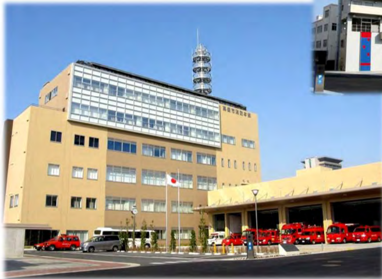
消防本部・中消防署合同庁舎
