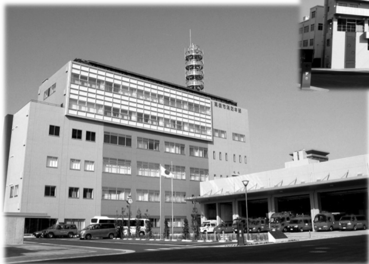
消防本部・中消防署合同庁舎
