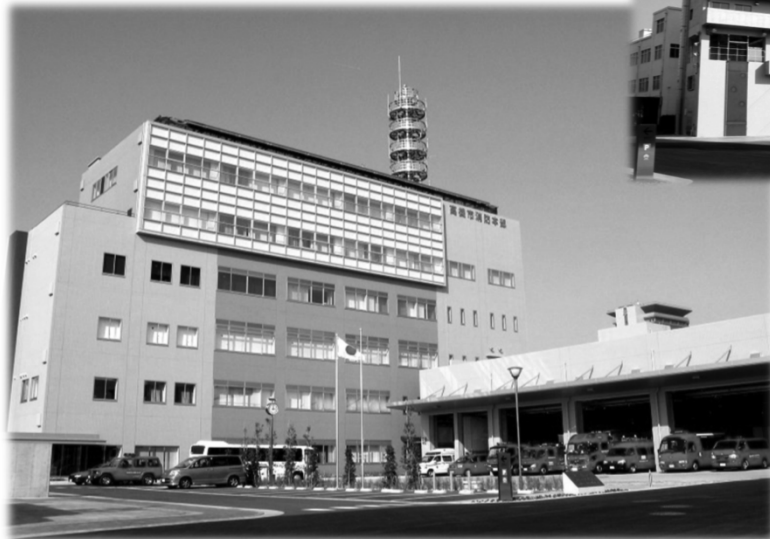
消防本部・中消防署合同庁舎
