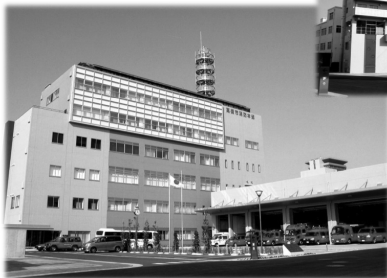
消防本部・中消防署合同庁舎
