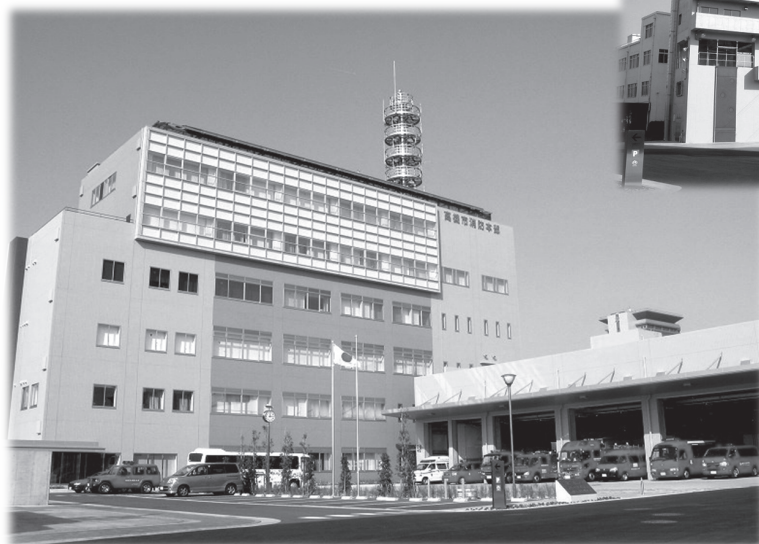
消防本部・中消防署合同庁舎
