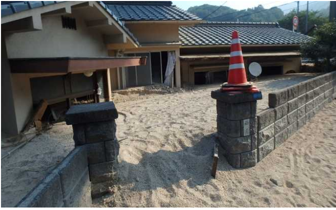
・被害状況（小屋浦地区）
