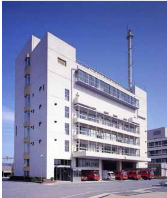
消防本部・中消防署（合同庁舎）
