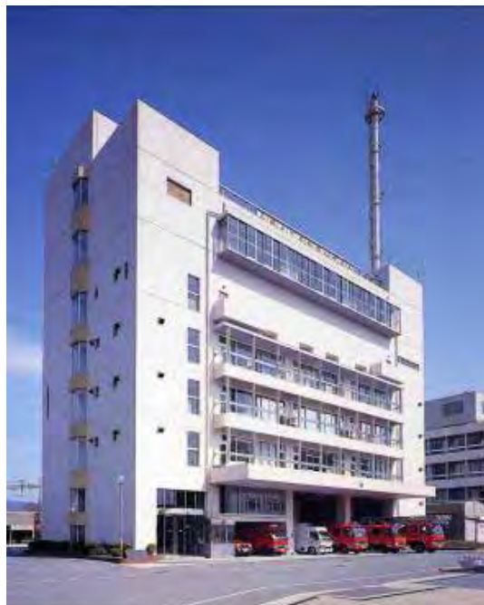
消防本部・中消防署（合同庁舎）
